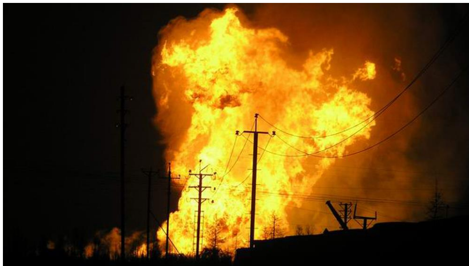
Рисунок 1.11 – Пожар на газораспределительной станции в городе Ульяновск
