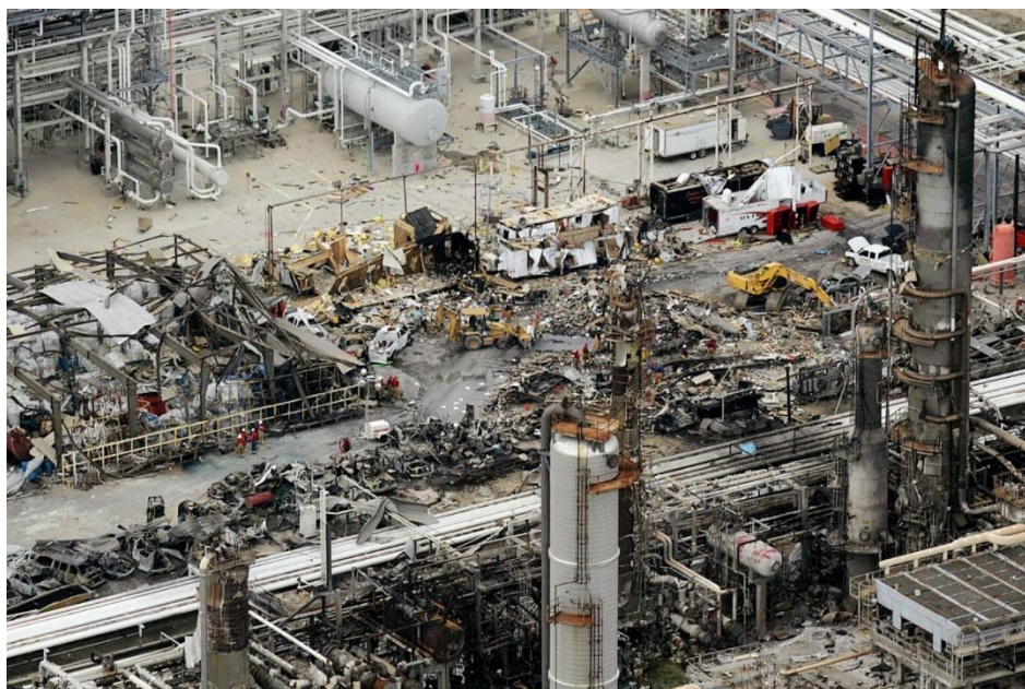
Рисунок 1.12 – Последствия пожара на газораспределительной станции в поселке Щелковская
